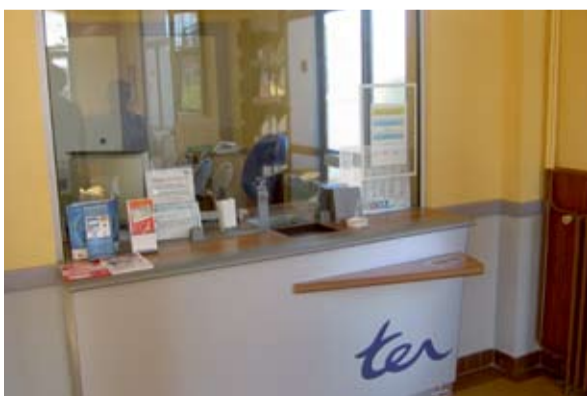
Pour les personnes en fauteuil, un guichet de vente surbaissé a été aménagé.
